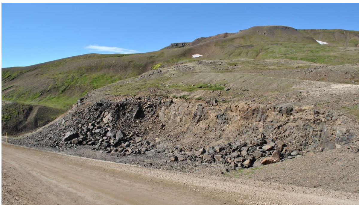
Mynd 4: Klappar skerðing í Neðra – Vatnsskarði (Sprengibrekku).
